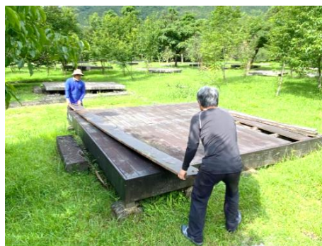
露營板位修護
