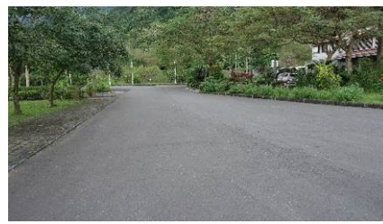
柏油鋪設完成現況
