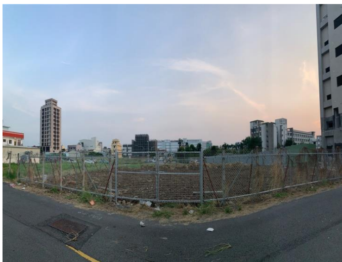
109.10.15 完成三面圍鍍鋅菱形圍籬+馬路側面4公尺出入大門
